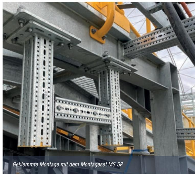
Geklemmte Montage mit dem Montageset MS 5P
