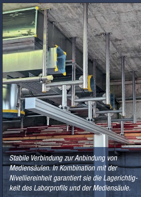
3-dimensionales Befestigungsrastrer für Bereiche mit hoher Installationsdichte und hohen Anforderungen an die Flexibilität.
