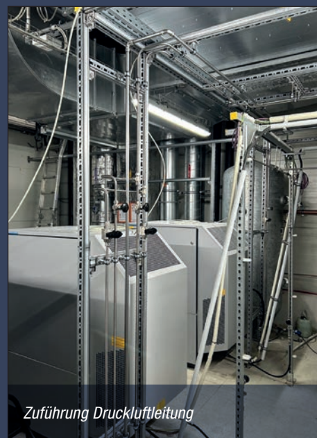
3-dimensionales Befestigungsrastrer für Bereiche mit hoher Installationsdichte und hohen Anforderungen an die Flexibilität.
